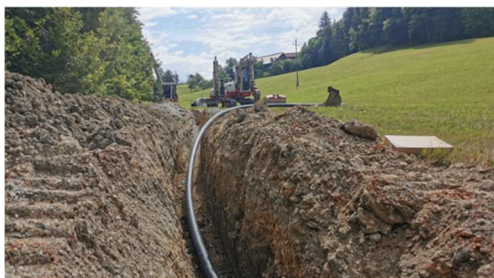
Slika 2. Gradnja vodovoda, Hramše
