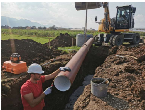
Slika 3. Izgradnja kanalizacije v Šempetru
