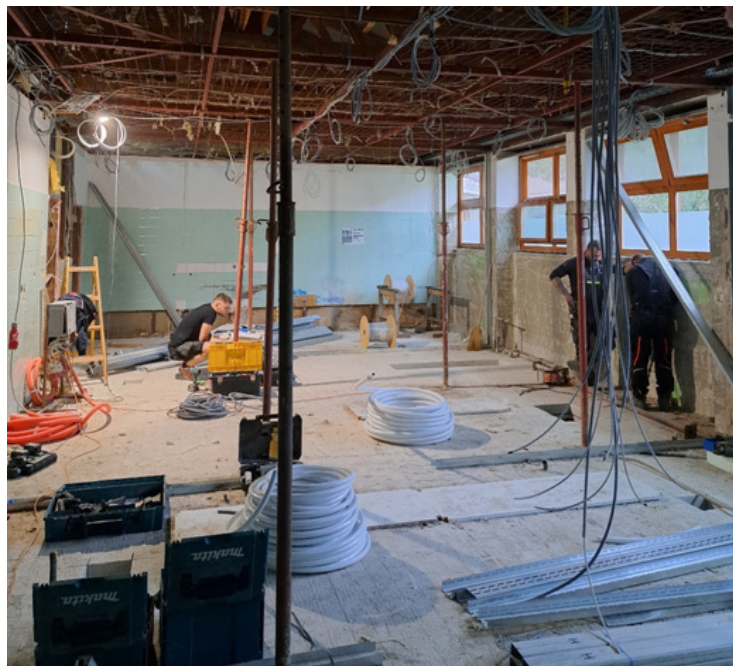
Gradbišče v Vrtcu Prebold
