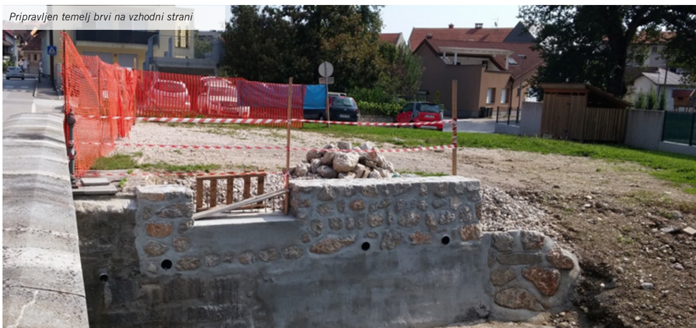
Pripravljen temelj brvi na zahodni strani
