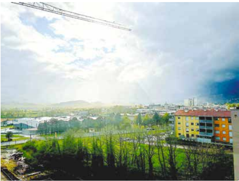
Pogled na gradbišče Papillon2
