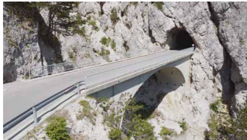
Armirano betonski most, po izgledu in trajnosti, prekaša marsikaterega mnogo mlajšega. Foto Aljaž Velikonja. Fototeka GDP.
